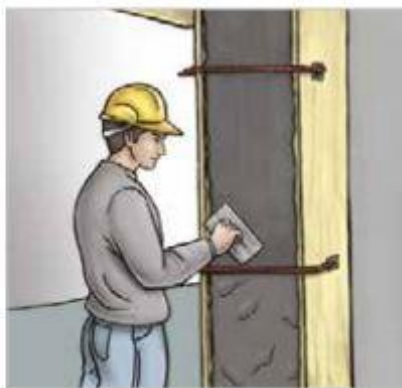
■ Rasatura, finitura e protezione con CONCRETE FINISHER.
