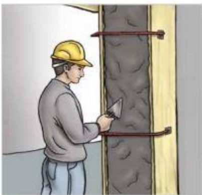
■ Ricostruzione della sezione mancante con le malte tixotropiche FLUECO (FLUECO 40T, 55T o 80T).
