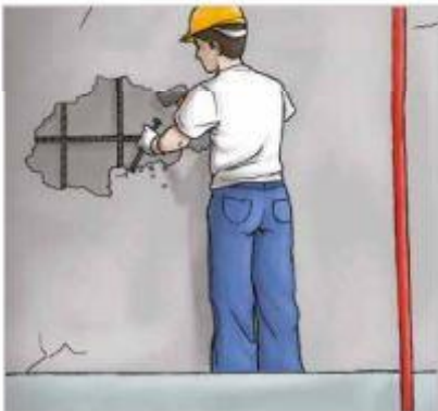
■ Eliminazione delle parti incoerenti del calcestruzzo ammalorato.
